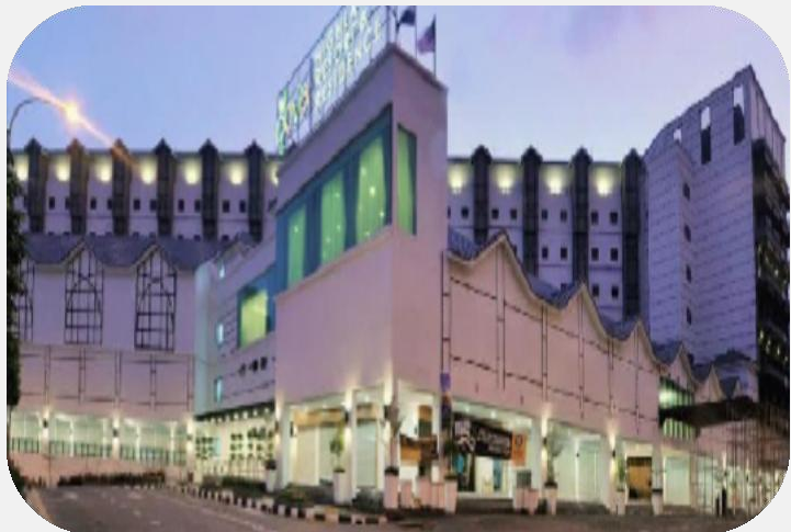
Cameron Square, Pahang 金馬倫新天地廣場
